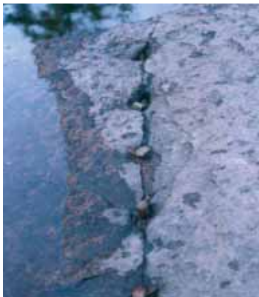
En rad med kiler sitter ennå i fjellet ved Rompetrolldammen.
