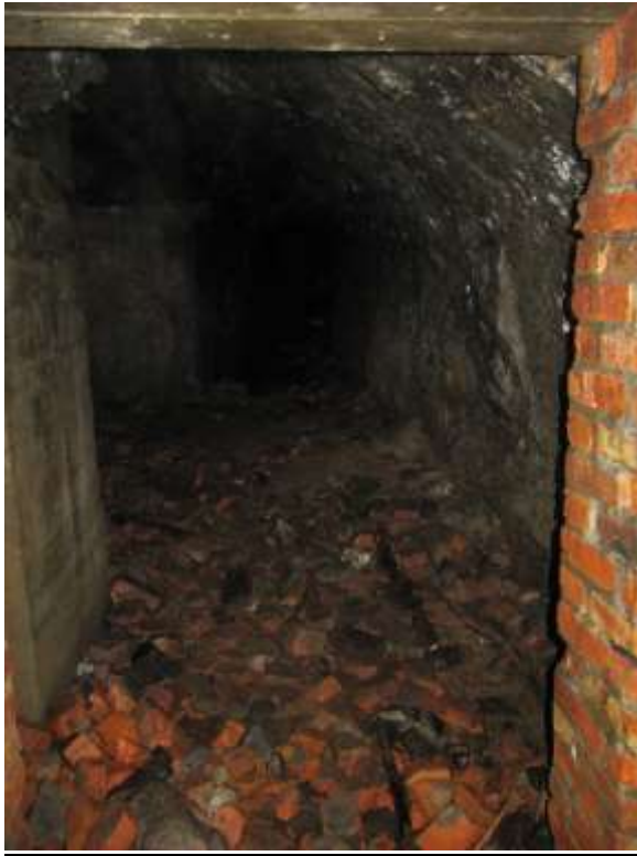
95B. Fra tunnelen ved Koåsbakken jan 2020
