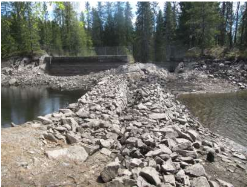
Foto 9. mai 2020 da demningene på Breisjøen var under oppgradering og vannet tappet ned
