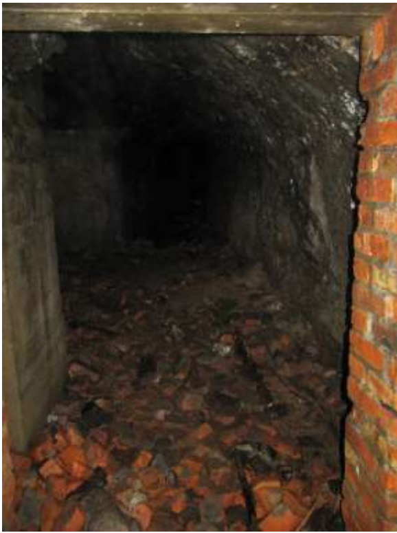
95B. Fra tunnelen ved Koåsbakken jan 2020
