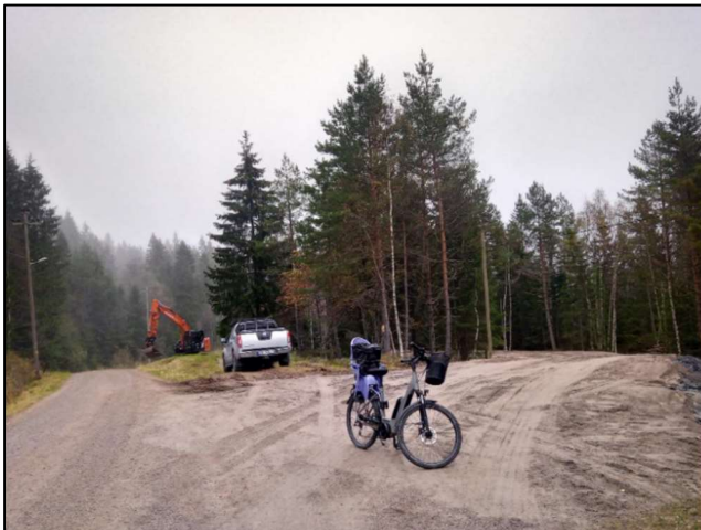
Den nye snuplassen nedenfor Lilloseter under anlegg. Foto: Håvard Pedersen
