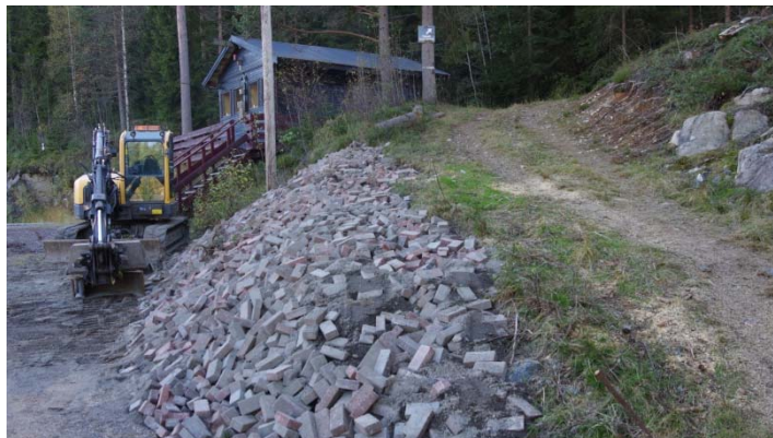
Bruk av store mengder betongstein som fyllmateriale. ved skiskytterbua, Bjønndalen skianlegg
